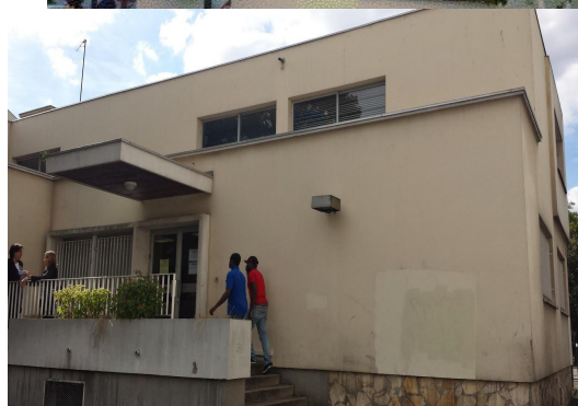
Arrière du bâtiment avec entrée actuel
