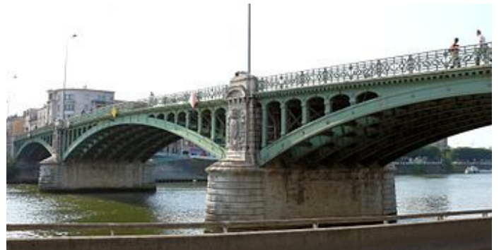
Pont de l'île Saint-Denis
